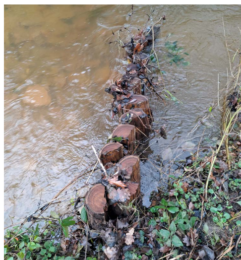
Epi deflecteur installé sur le Lameron (5 décembre 2025 - ©ARRA²)
