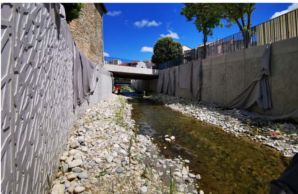
Vues sur les travaux de découverte de la Savasse, de l'amont vers l'aval
