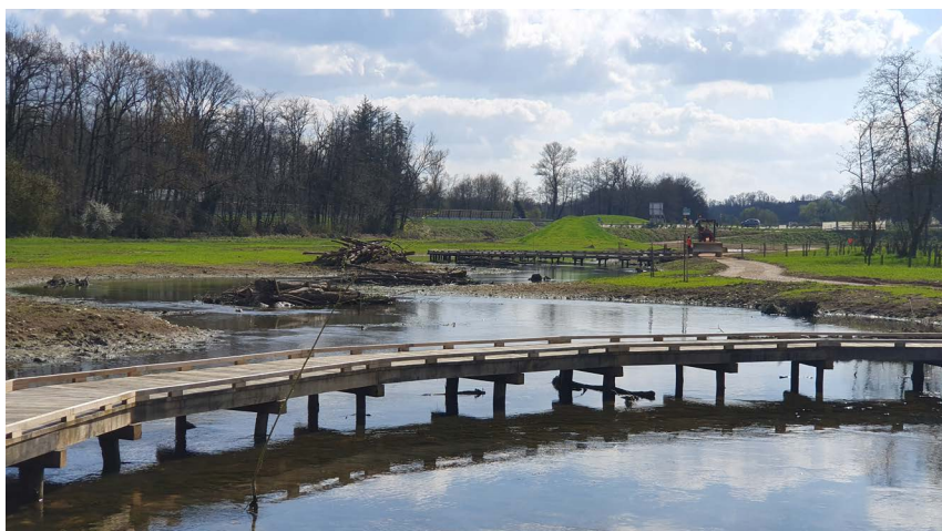
Restauration de la Reyssouze dans le site de Bouvent (© N. Valé - ARRA²)
