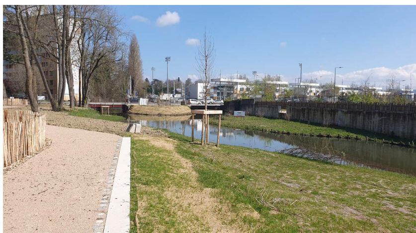
Restauration de la Reyssouze dans sa traversée le long de l'allée de Challes (© N. Valé - ARRA²)
